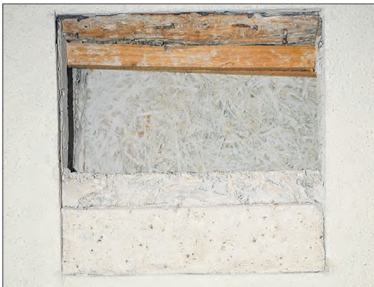
Im Gebäude sind 14 Sondagen zu finden. Hier sind Ausfachungen aus den 1960er-Jahren und ein Holzbalken von 1624/25 zu erkennen.
